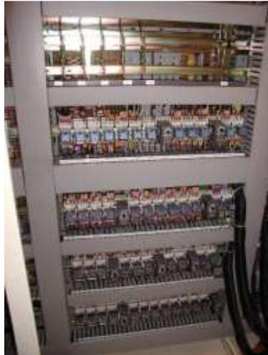
Ilustración 2.4. Rack de lógica cableada con relés electromecánicos y relés temporizados electrónicos
