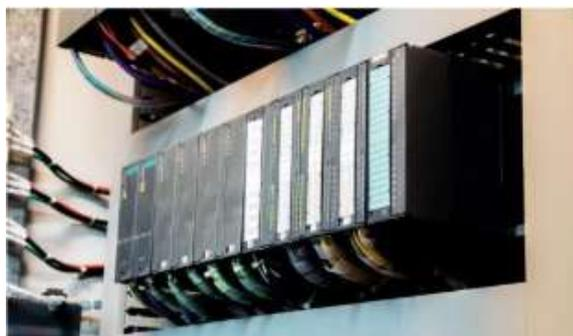
Ilustración 2.8. Controlador lógico programable (PLC) de gama alta
