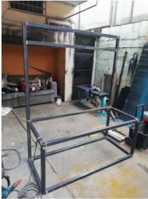
Figura 67 Armazón de la estructura Fuente: Harold Gherardy
