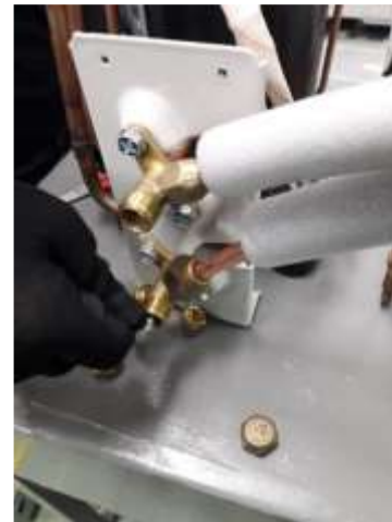
Figura 37 Apertura de llaves de válvula de servicio Fuente: Harold Gherardy
