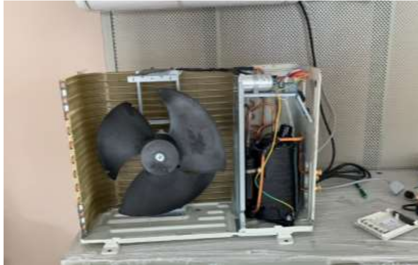
Figura 28 Interior de la Unidad Condensadora Fuente: Harold Gherardy
