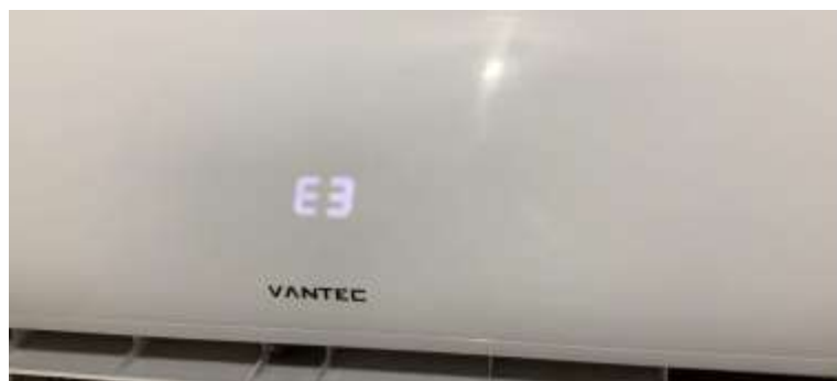
Figura 42 Mensaje de Error del sensor evaporador
