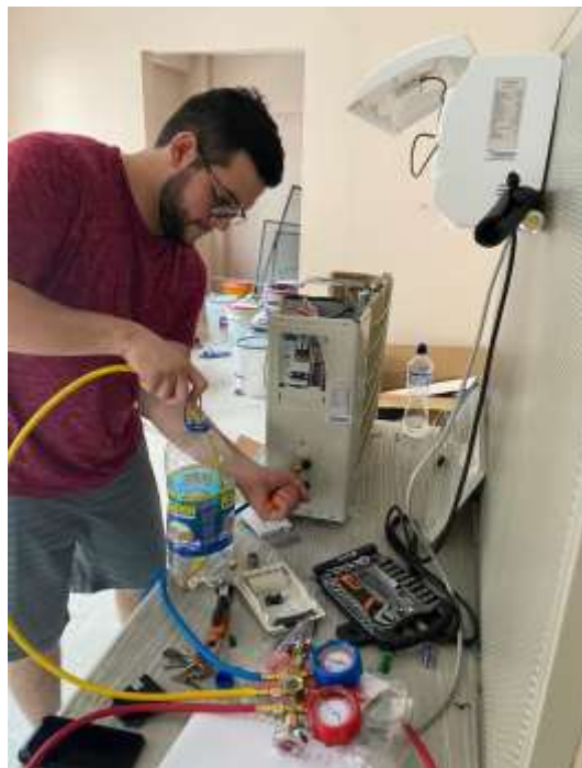
Figura 29 Proceso del vacío del compresor Fuente: Harold Gherardy
