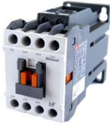
Figura 2.8.:IEC Contactor, MC-18a, 120VAC Fuente: (Takaya, 2017, pág. 32)
