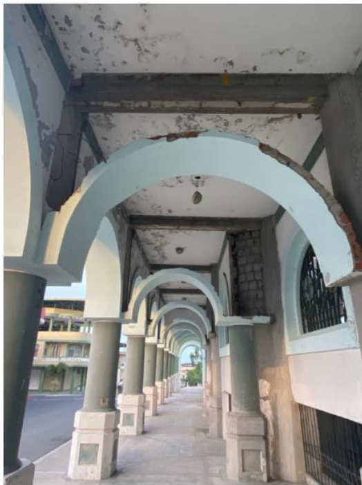
Ilustración 29 Caída de mampostería interna y externa de la Catedral de la Dolorosa, Manta
