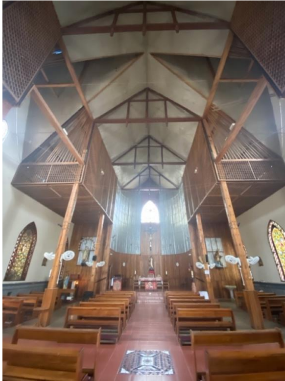
Ilustración 31 Interior de la iglesia de La Merced, se puede observar los pilares y el altar de madera junto con otros elementos rústicos tal como se uso en el modelo original.
