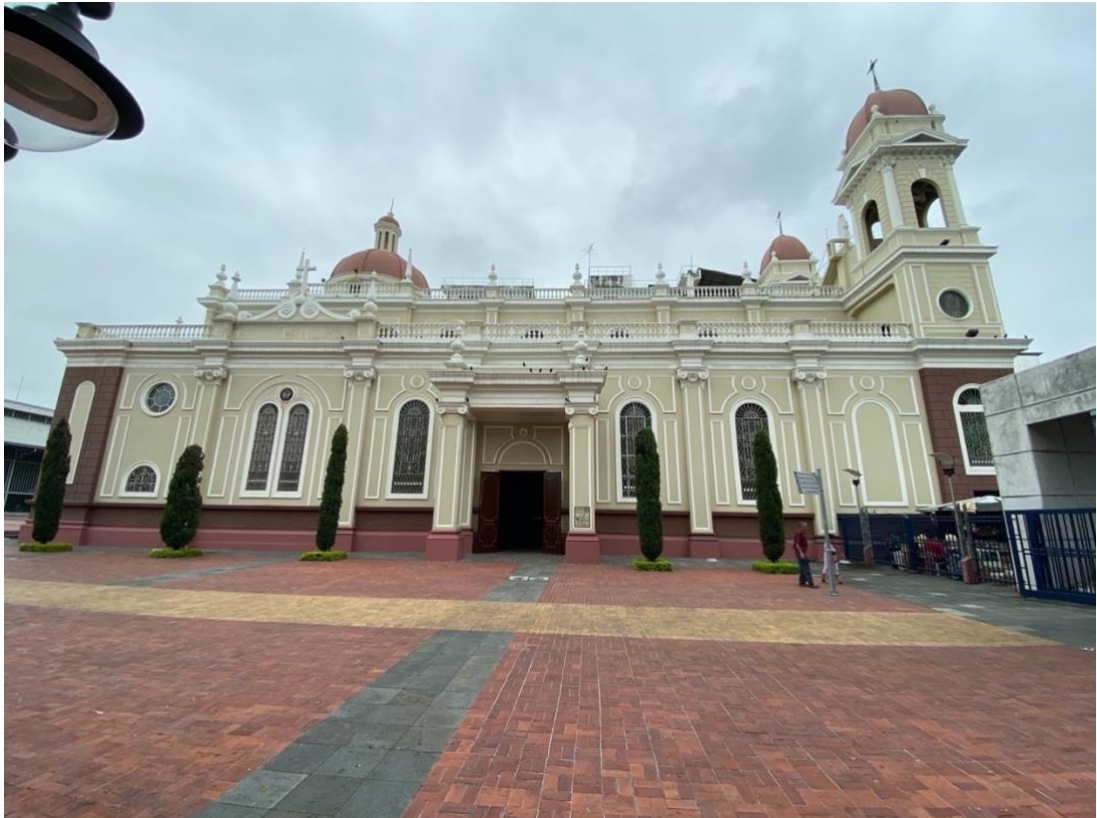
Ilustración 15 Vista lateral de la iglesia San José, se puede apreciar el estilo Lombardo.
