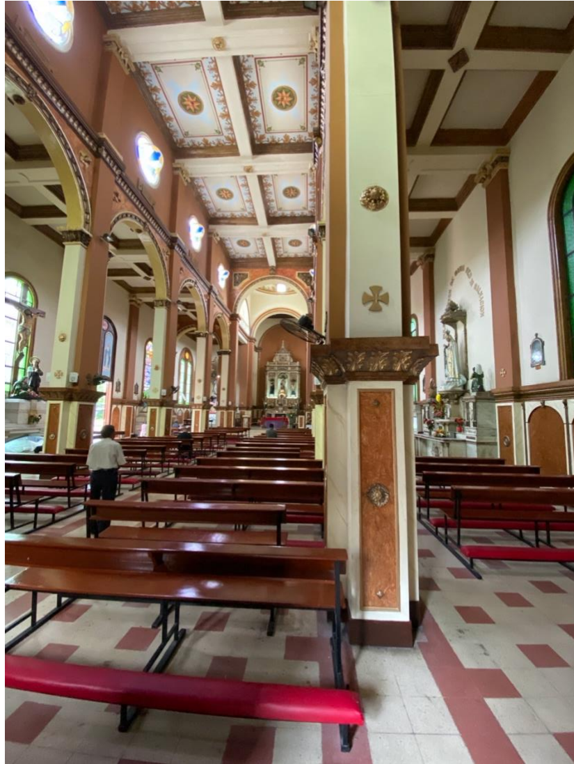
Ilustración 16 Interior de la iglesia San José, se observa el desnivel de las naves y la separación de pilares cada 5 metros.
