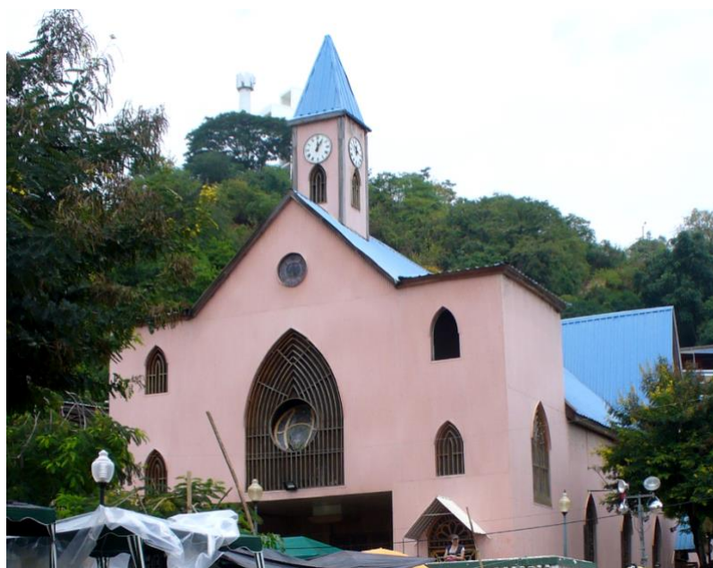
Ilustración 30 Iglesia de La Merced en Bahía de Caráquez, no presento daños. Obtenida de Ing. Alex Villacrés.
