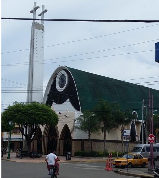
Ilustración 24 Iglesia de La Merced en Portoviejo, no presenta daños graves.
