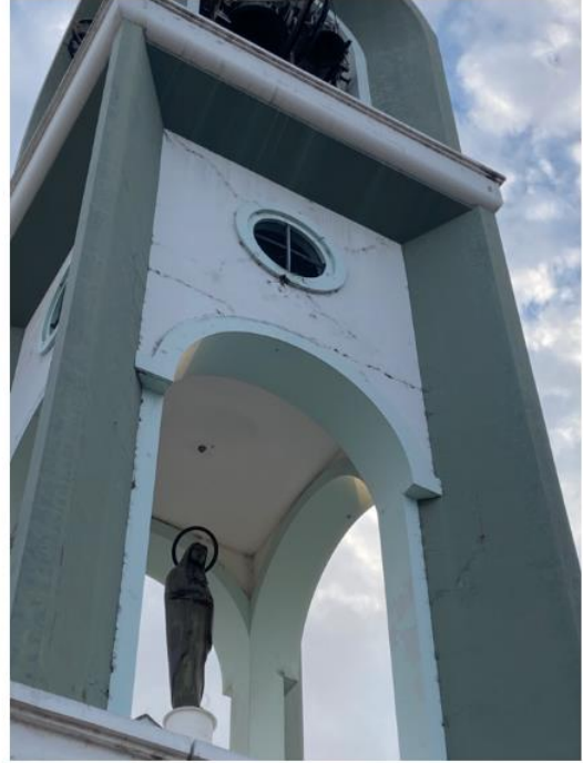
Ilustración 28 Fisuras en la torre del campanario de la Catedral de la Dolorosa, Manta
