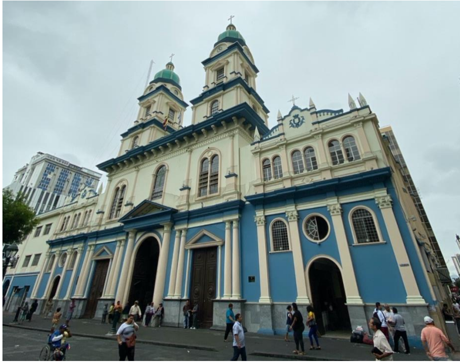
Ilustración 19 Estado actual de la iglesia San Francisco.
