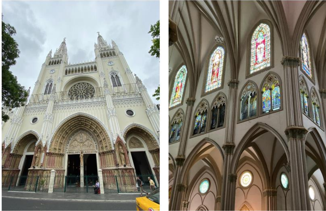
Ilustración 11 Malla de protección para evitar que la caída de algún escombros o ventanal producto del movimiento durante los sismos. Fuente Andrei Moreno.
