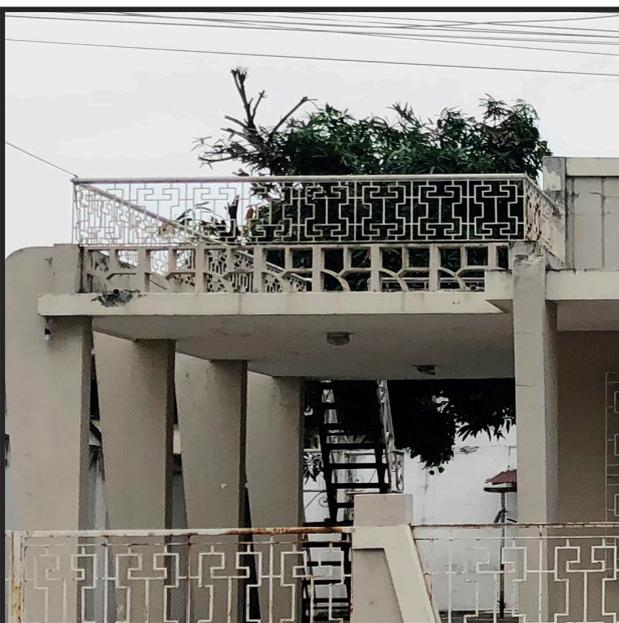
Inmueble unifamiliar de hormigón armado. Se percibe un retranqueo de planos, dividiendo el volumen en dos módulos que, al mismo tiempo, se unen por medio de un elemento horizontal tipo losa, generando un espacio de transición cubierta en la entrada principal. Esta losa se alarga de la forma que cubre el área de parqueo de la vivienda, sosteniéndose por medio de una serie de columnas.
