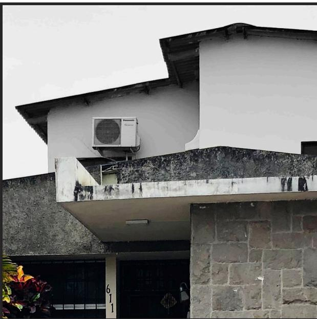
Inmueble unifamiliar de hormigón. La edificación se compone de un volumen principal con cubierta de dos aguas, en cuya fachada se observa un acabado tipo martillado al hormigón para cambio de textura, al cual se le realiza una adición de un módulo prismático con losa plana con volados de hasta 1 metro a los lados generando espacios abiertos/cubiertos.
