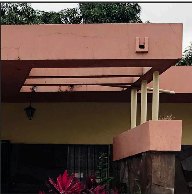
Inmueble unifamiliar de hormigón armado con cubierta tipo losa. Se percibe un retranqueo de planos para crear un espacio de estancia en la entrada principal, la losa se alarga de tal manera que cubre este espacio y se sostiene por medio de una columna revestida de piedra. A la losa se le realiza una sustracción, generando 3 vanos en ella logrando ligereza visual. Además, en la fachada principal se observan ventanas amplias que miran hacia el jardín frontal, y un cambio de textura en las paredes.
