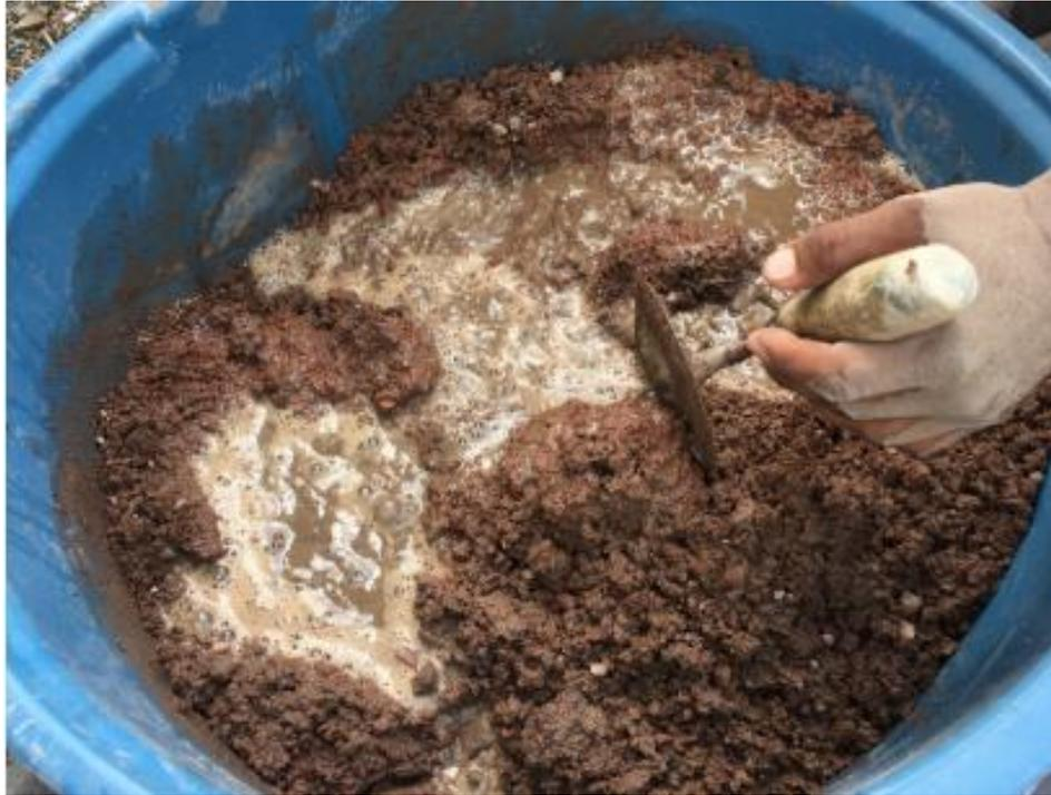
**Figura 11.- Adición de aditivo inclusor de aire para la mezcla de concreto en la alternativa uno.**
