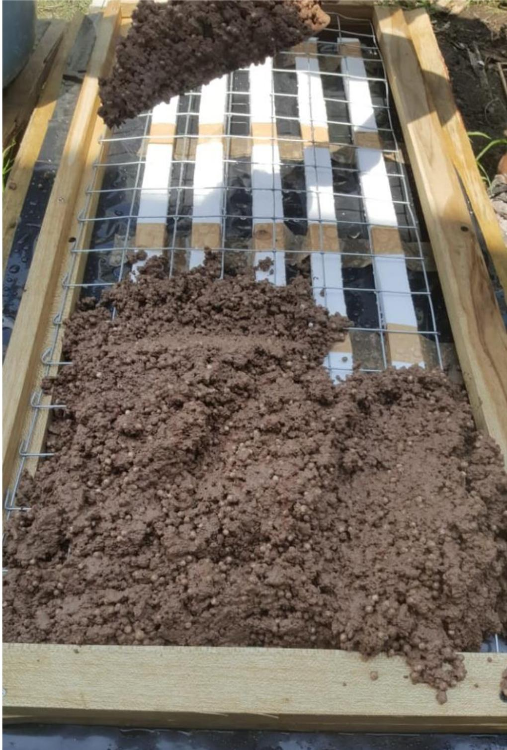
**Figura 15.- Colocación del material en el encofrado.
