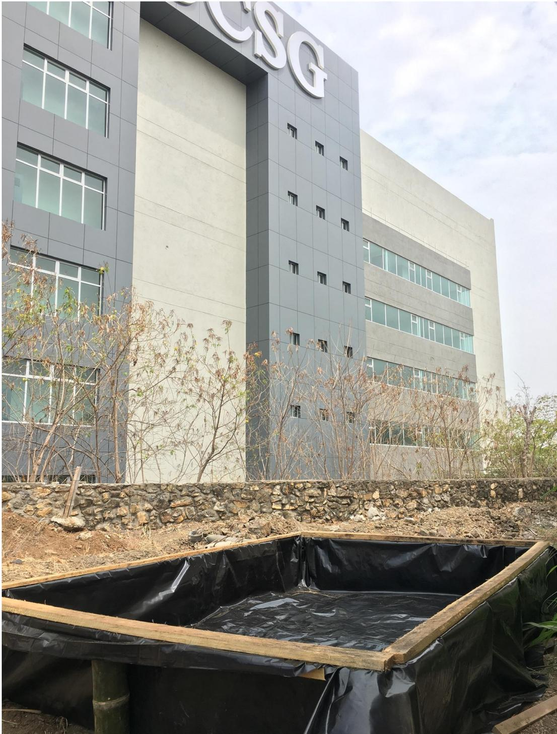
**Figura 18.- Piscina artesanal destinada para el curado de las placas.
