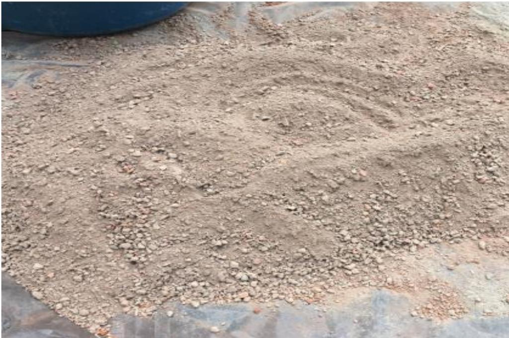
**Figura 10.- Adición del cemento local tipo GU al material todo uno.
