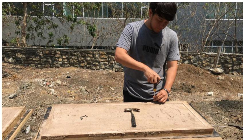
**Figura 17.- Desencofrado de las placas.**
