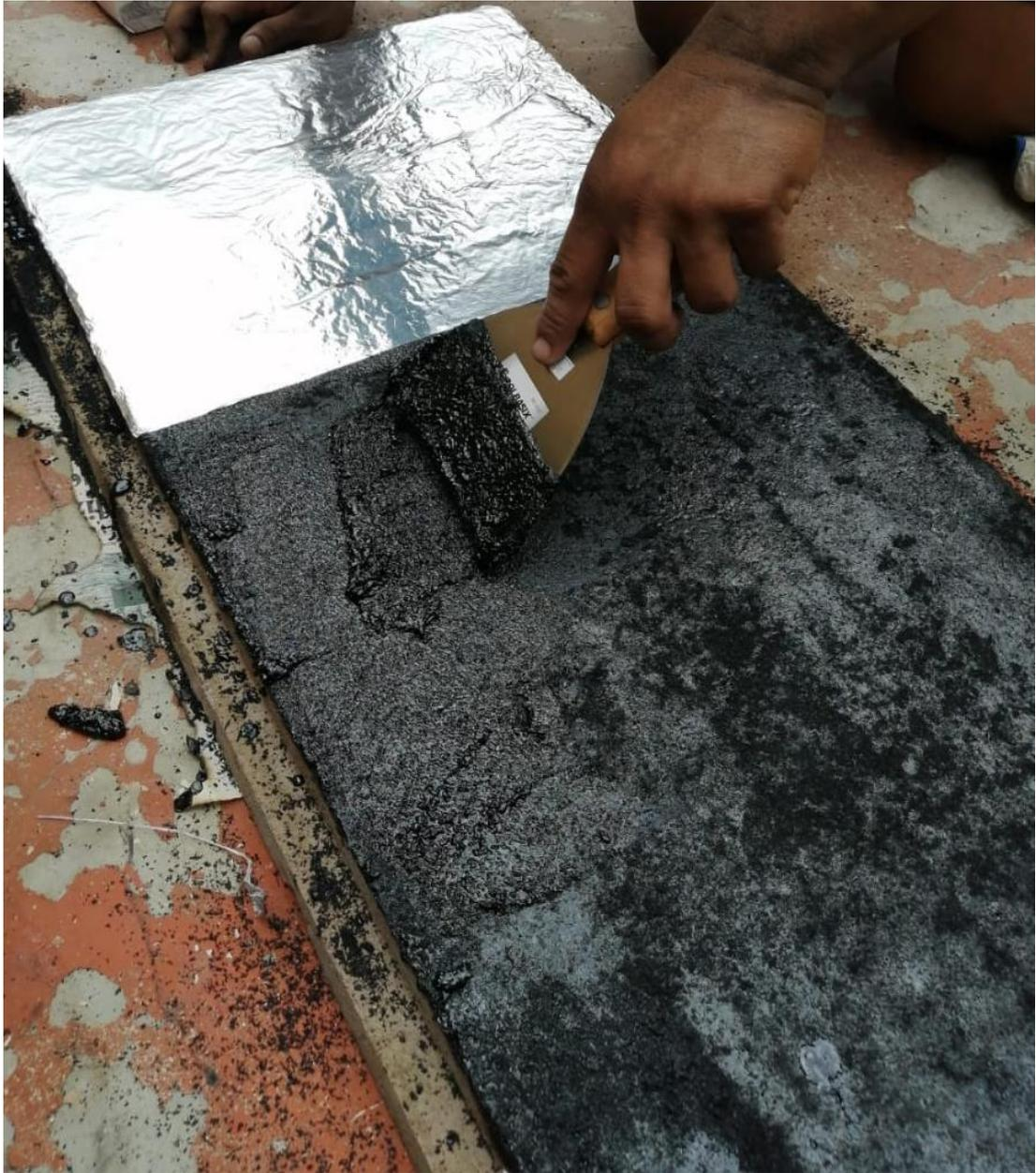
**Figura 28.- Colocación de la pasta impermeabilizante a la placa.
