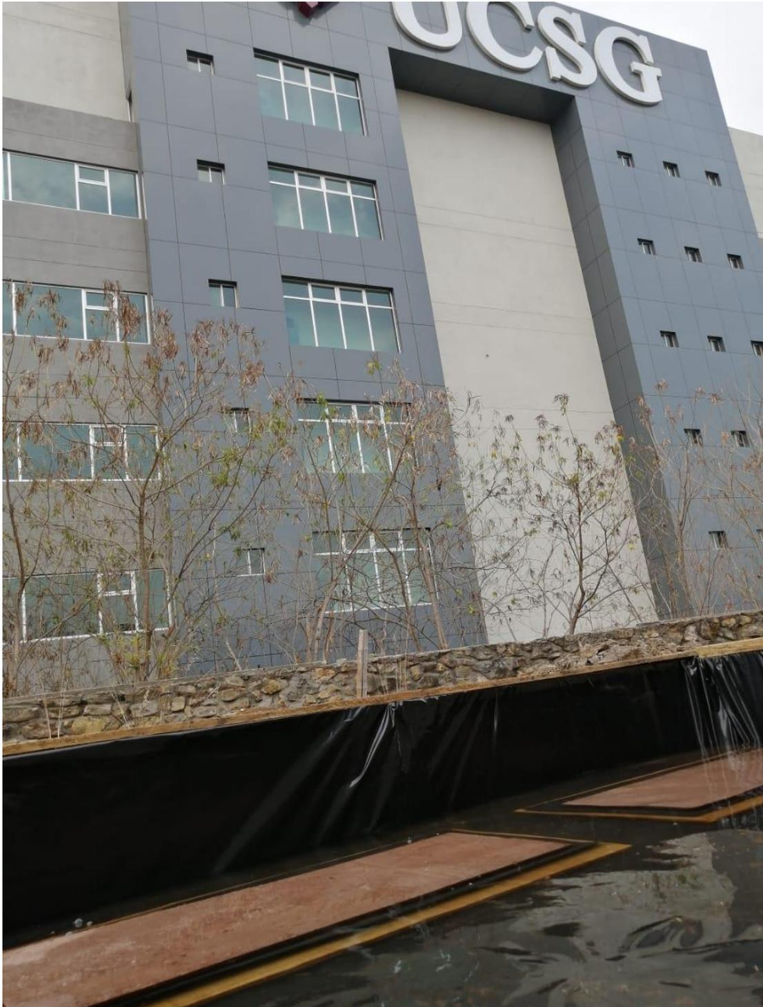
**Figura 19.- Sistema de curado en agua de la Placa Plana UCSG.
