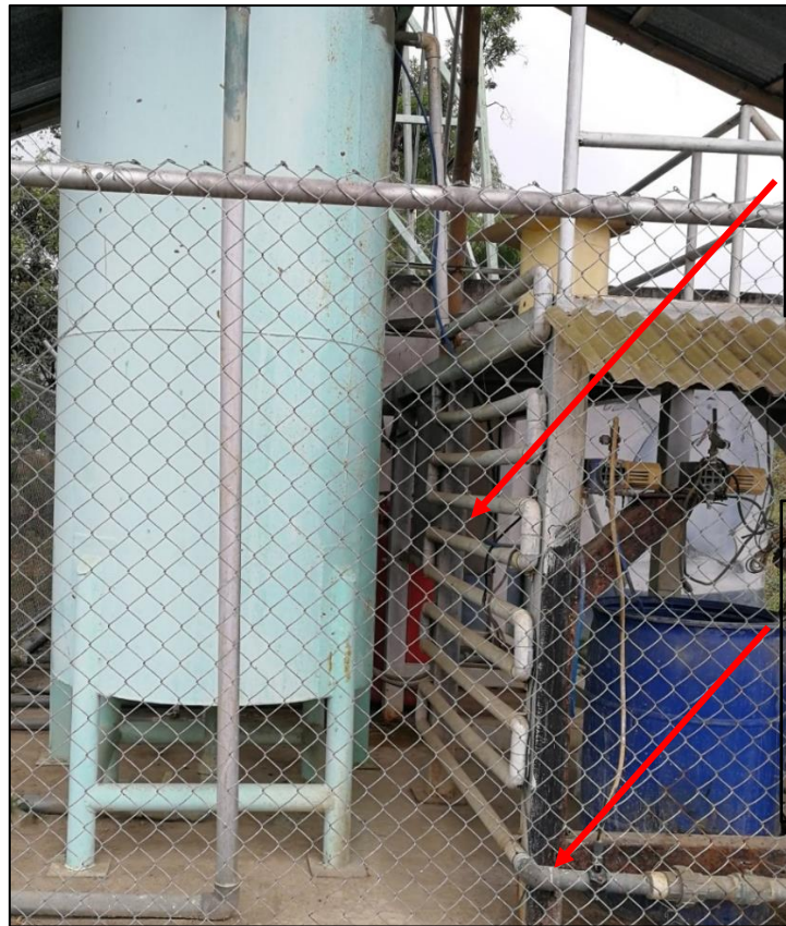
Ilustración 33.- Línea de conducción, tubería de acero inoxidable y zona de aplicación del coagulante.
