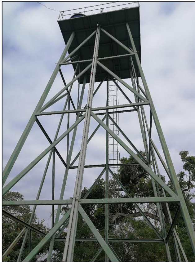
Ilustración 54.- Torre metálica, donde están asentado los tanques elevados.
