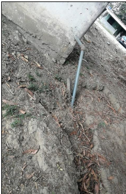
Ilustración 28.- Sistema de captación del agua.
