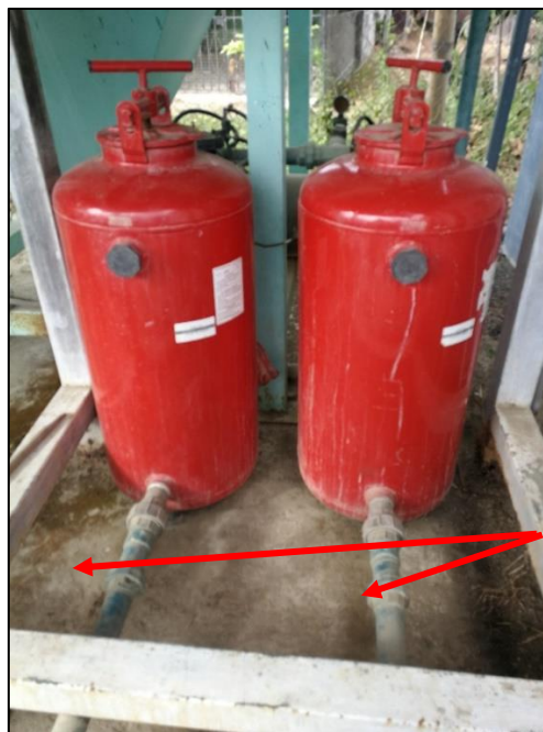
Ilustración 47.- Tanques filtro.
