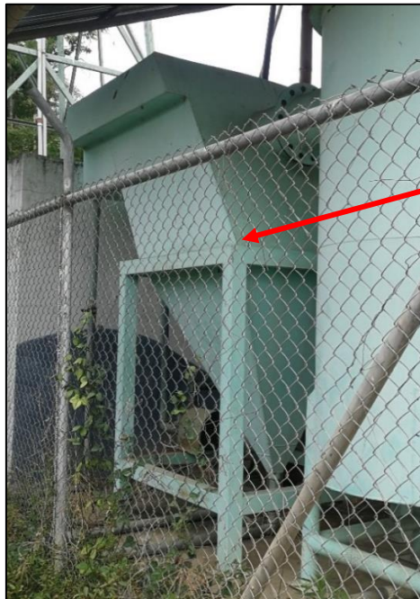
Ilustración 40.- Tanque sedimentador.
