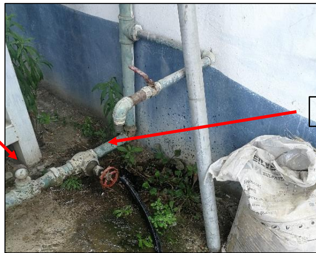
Ilustración 49.- Presencia de manómetro en la línea de conducción que se dirige hacia el primer reservorio de almacenamiento bajo.
