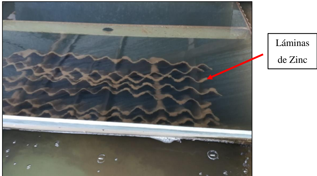
Ilustración 43.- Láminas de zinc en reservorio filtrante.
