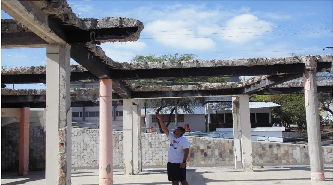
*Figura 21.* Fotografía de elementos estructurales que colapsaron en el terremoto del 16 de abril del 2016
