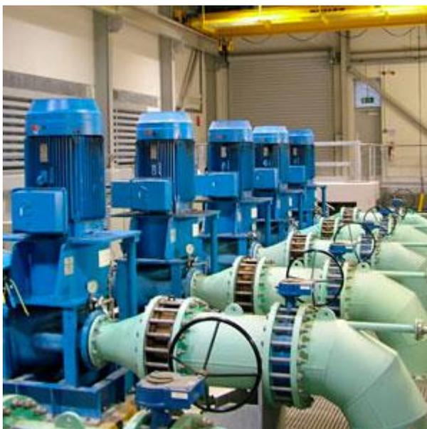
Figura 2.12: Equipos de bombeo para aguas residuales
