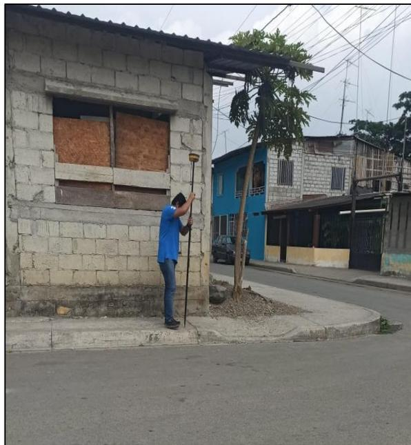
Figura 7.6 Toma de puntos georeferenciados sobre las veredas.
