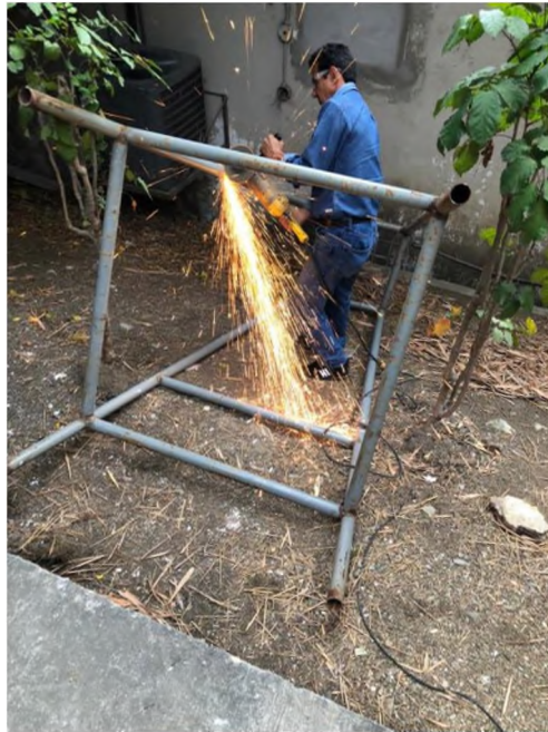
Fotografía 1 Torre para el almacenamiento de aguas residuales.
