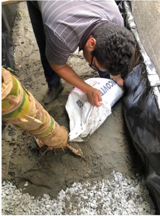
Fotografía 9: Colocación de Caña Guadua.
