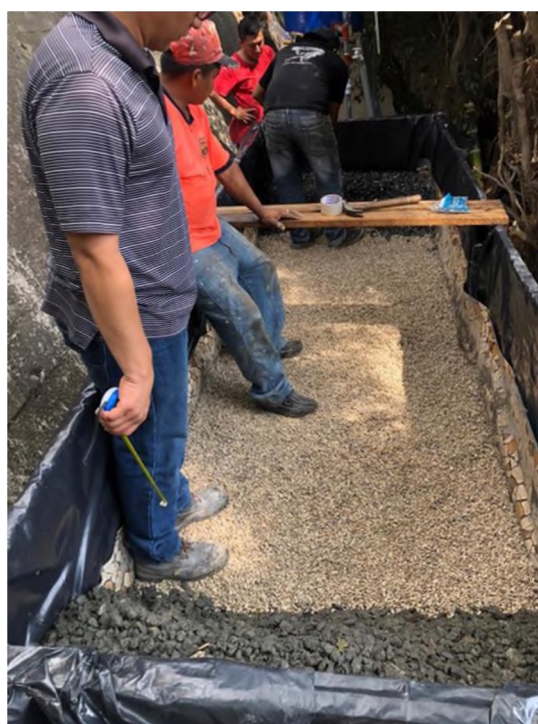
Fotografía 8: Colocación de los materiales filtrantes en la Planta Piloto.
