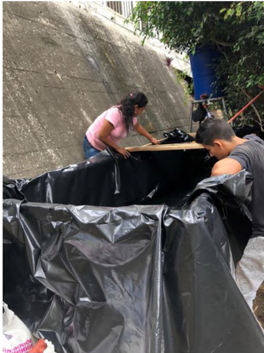
Fotografía 5: Impermeabilización de Planta Piloto.
