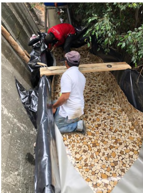
Fotografía 7: Colocación de Vinil sobre el impermeabilizante de la Planta Piloto.
