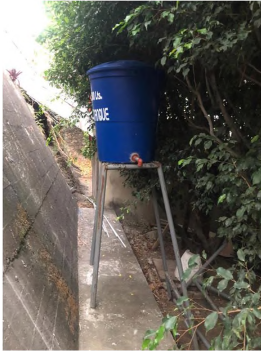
Fotografía 3: Torre y tanque homogeneizador para el almacenamiento de aguas residuales.
