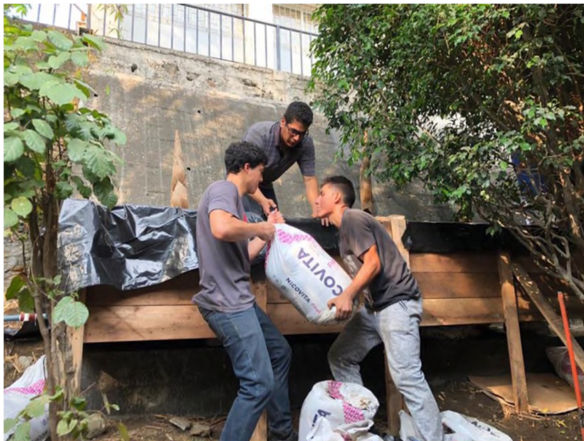
Fotografía 6: Colocación de Arena en Planta Piloto.
