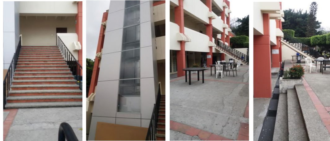
Figura 176. Exterior de la Facultad de Filosofía. Fuente: elaboración propia
