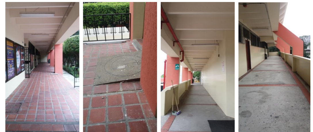
Figura 180. Pasillos del bloque aulas Fuente: elaboración propia
