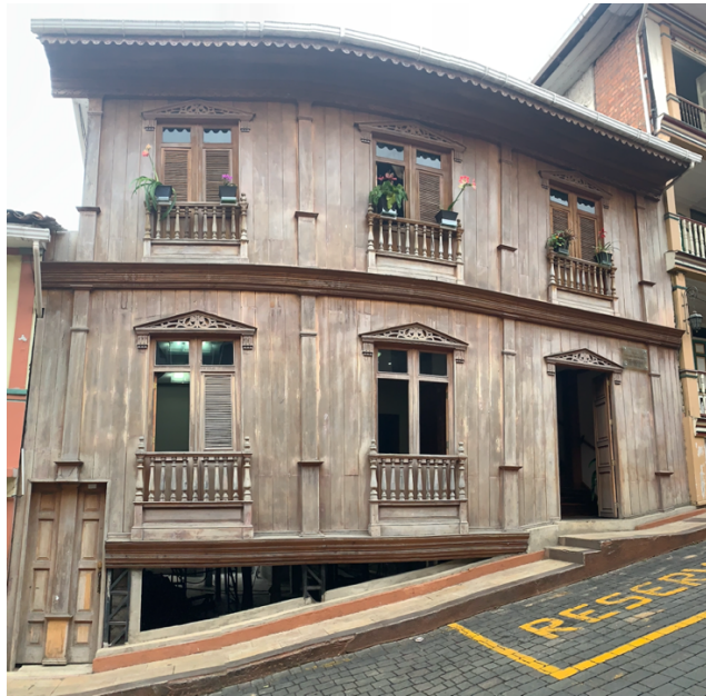
Figura 32: Fotografía de casa patrimonial ubicada en la calle 9 de octubre
