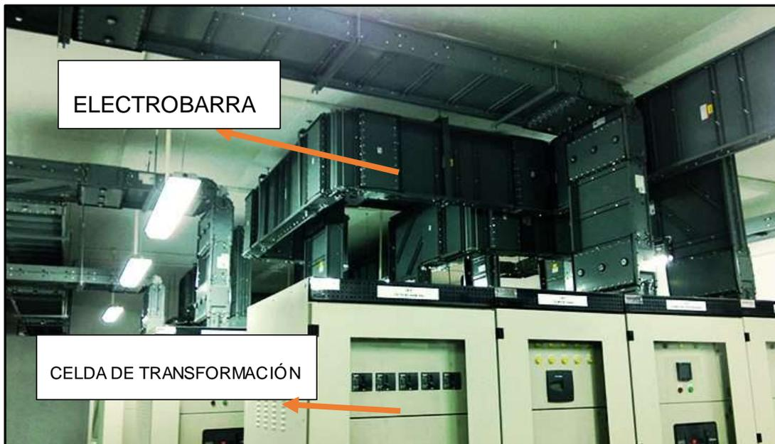
Figura 2.12: Distribución de energía dentro de edificios
