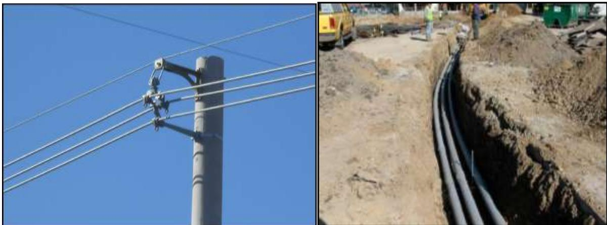
**Figura 2.3: Sistema de distribución aéreo y subterráneo.**
