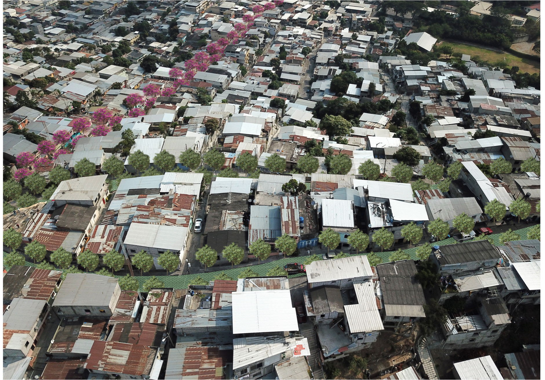
EJE PRINCIPAL CORREDOR A
