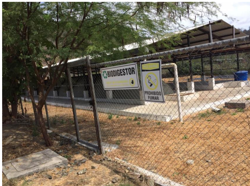
Anexos P Vista externa del biodigestor y laguna de desinfección
