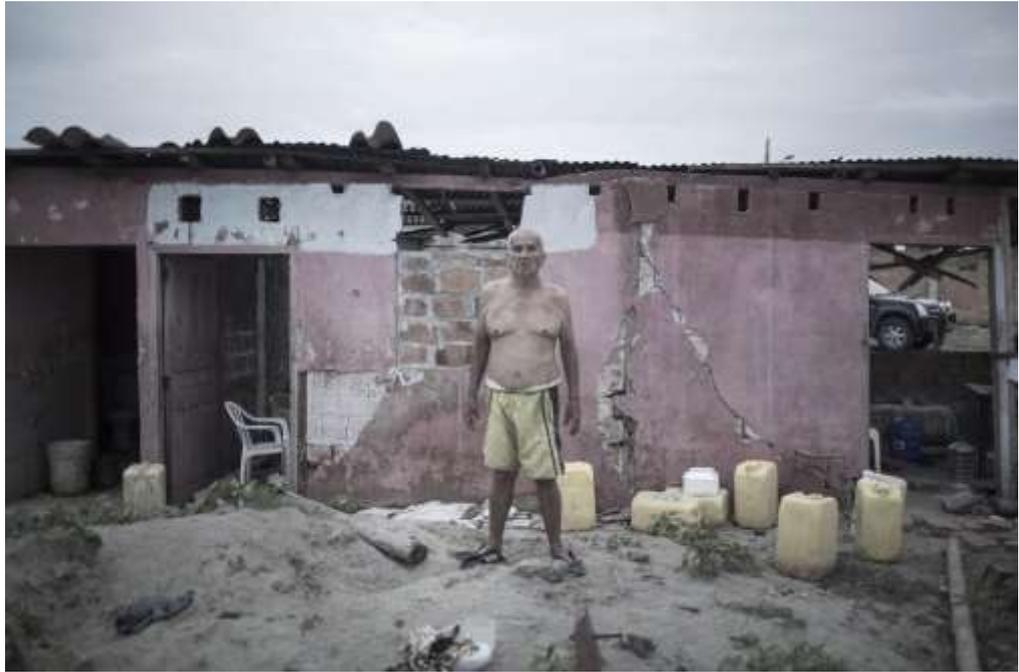
*Figura 1* restos de muros preexistentes donde se implementan nuevos cerramientos y cubiertas provisionales segundo mes después del terremoto. Fuente: Oscar Ospina
