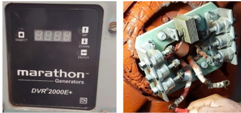
Figura 3. 10 Generador estribo DVR 2000E+, corona de diodos nueva
