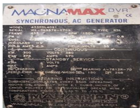
Figura 3. 12 placa de datos de generador de babor y estribo
