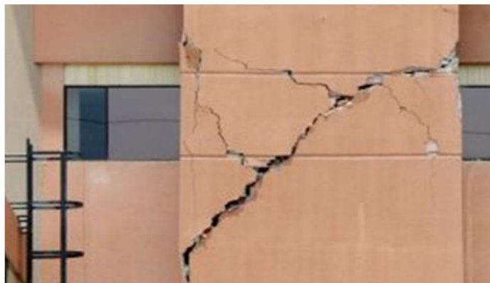
Ilustración 1. Colapso de edificio en Guayaquil. Fuente: Revista Vistazo
