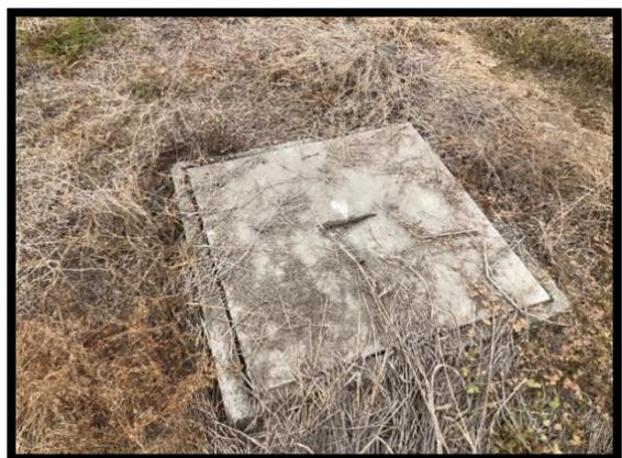
Foto # 10: Caja de registro del sistema de tratamiento de aguas residuales.
