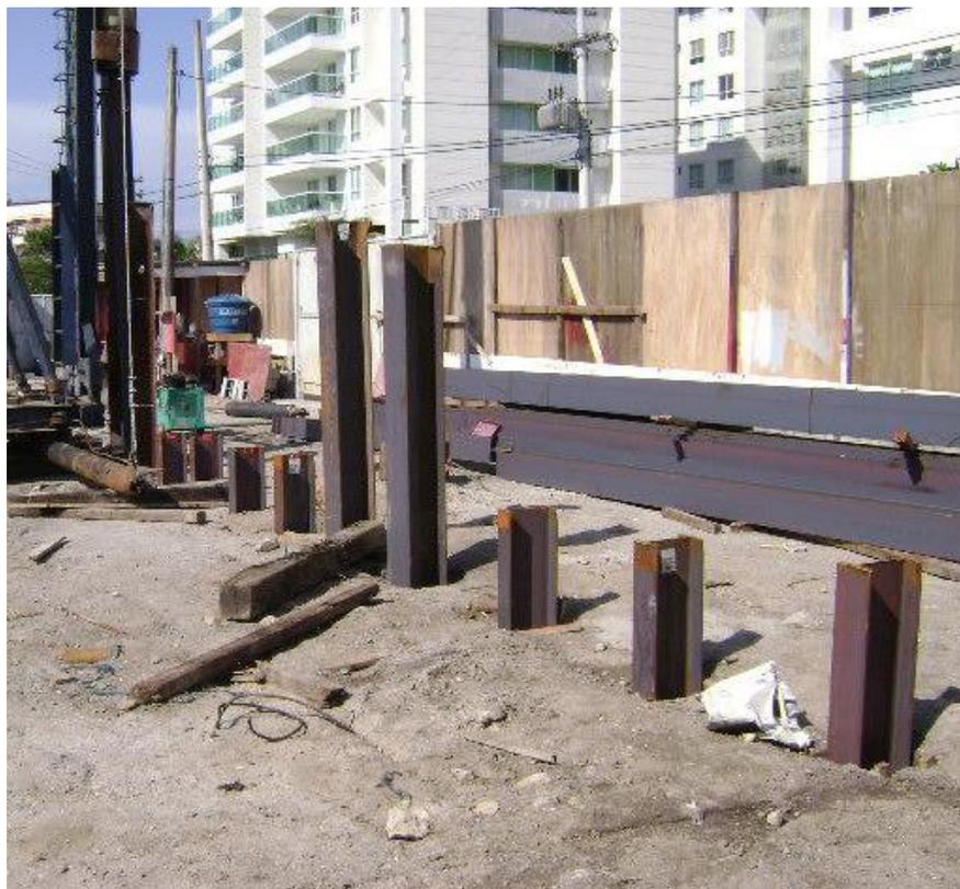
**Nota:** Reproducido de “*Estaca metálica cravada*”, por Martelos Hidráulicos, 1996 (<https://www.marteloshidraulicos.com.br/estaca-metalica-cravada>). Todos los derechos reservados [1996] por Martelos Hidráulicos.
