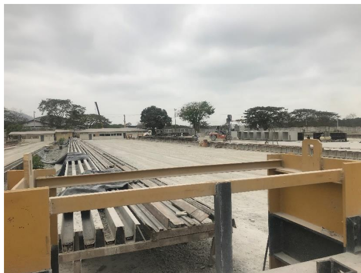
Ilustración 28 Molde para la fabricación de los elementos prefabricados de la empresa DITELME.
