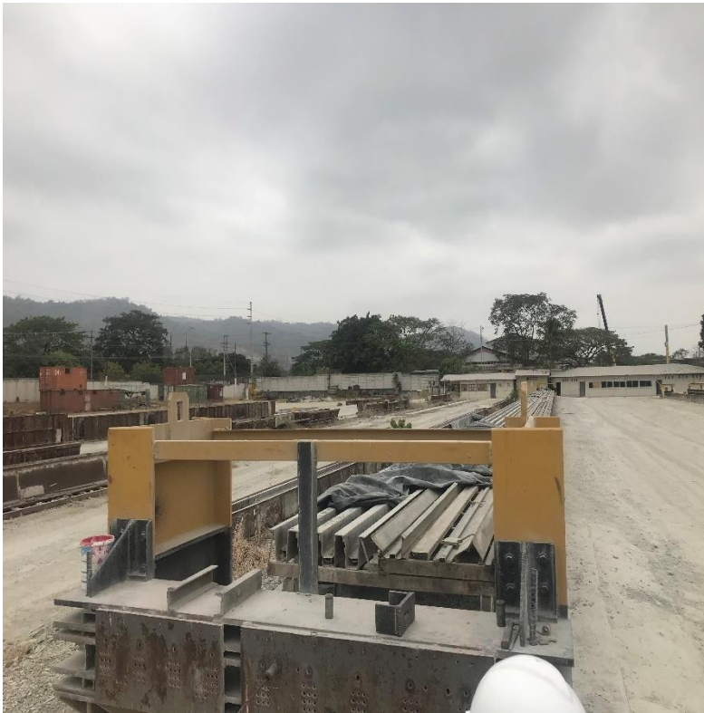
Ilustración 49 Molde de Vigas T para la fabricación del elemento.
