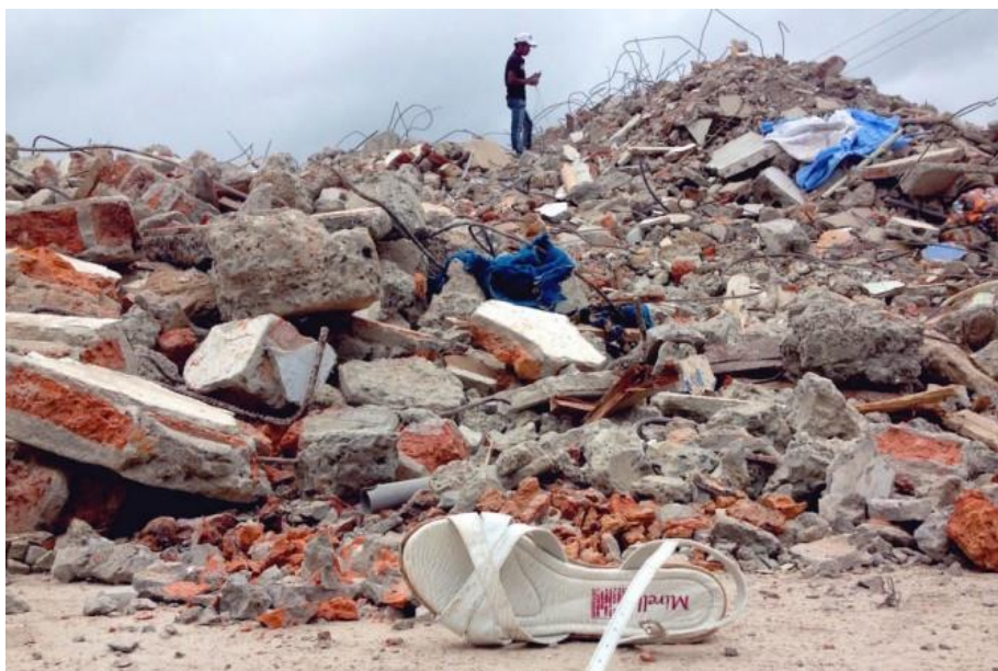
Ilustración 2. Escombros de edificaciones afectadas en el terremoto de Pedernales en el 2016 Fuente: https://terremoto.gk.city/pedernales-la-gente-pide-la-lista-los-fallecidos/
