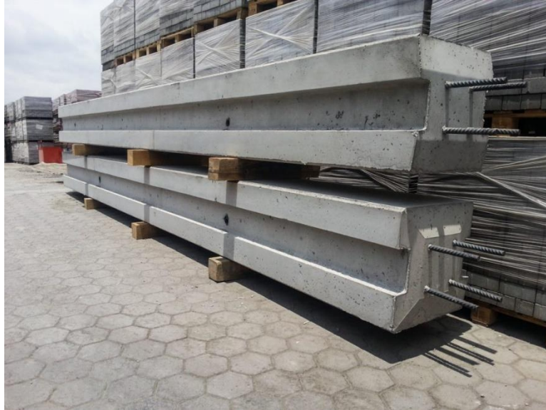
Ilustración 27 Elementos estructurales elaborados con materiales prefabricados
