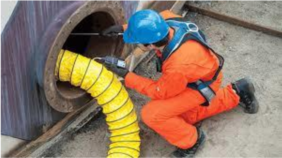
Ilustración 12: Prueba Inicial de las atmosferas en espacios confinados.
