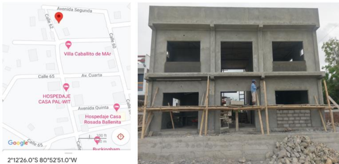
Ilustración 31: Ubicación y Fachada de Vivienda de dos Plantas.
