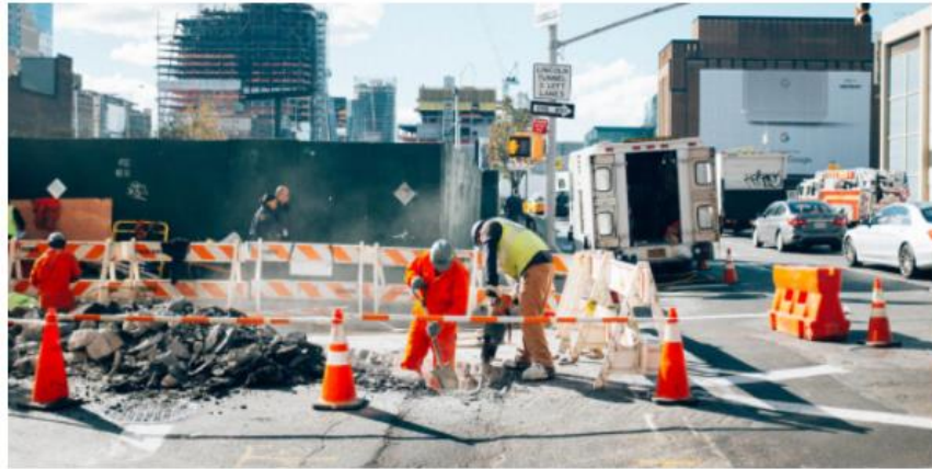
Ilustración 29: Instalación de señalización preventiva en zonas limitadas.
