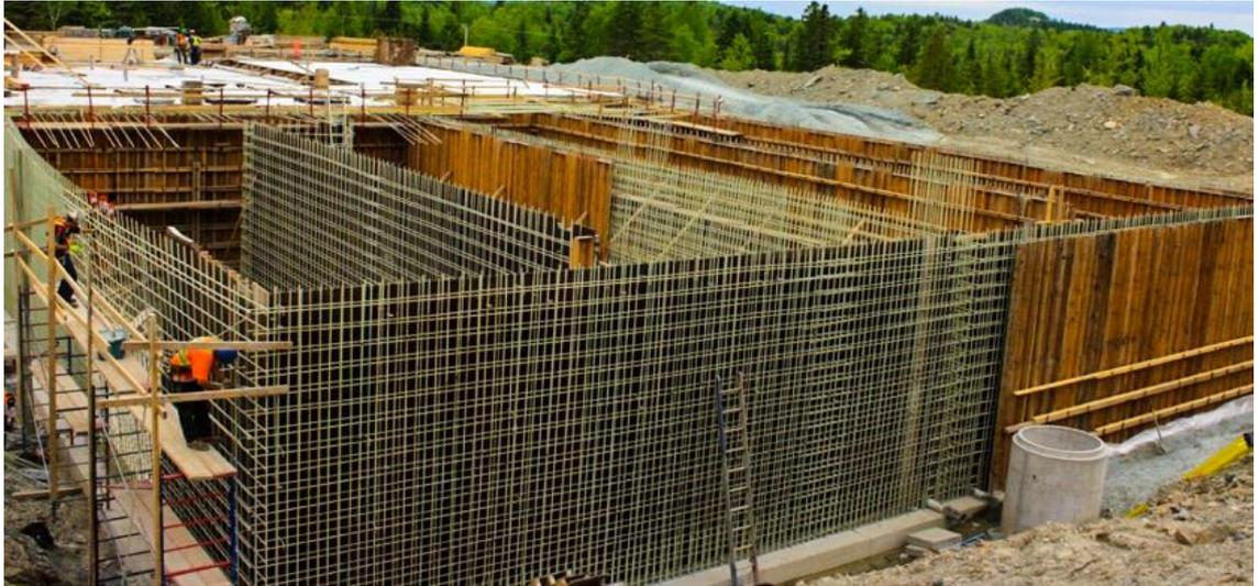
Figura 13: Muros de contención con varillas GFRP. (Tufbar, 2020)
