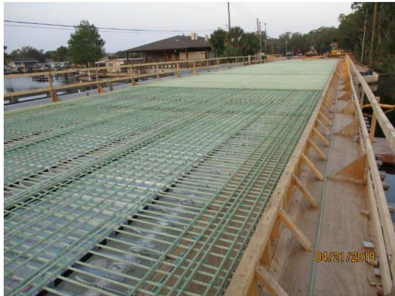
Figura 14: Varillas GFRP para construcción de tablero. (Tufbar, 2020).
