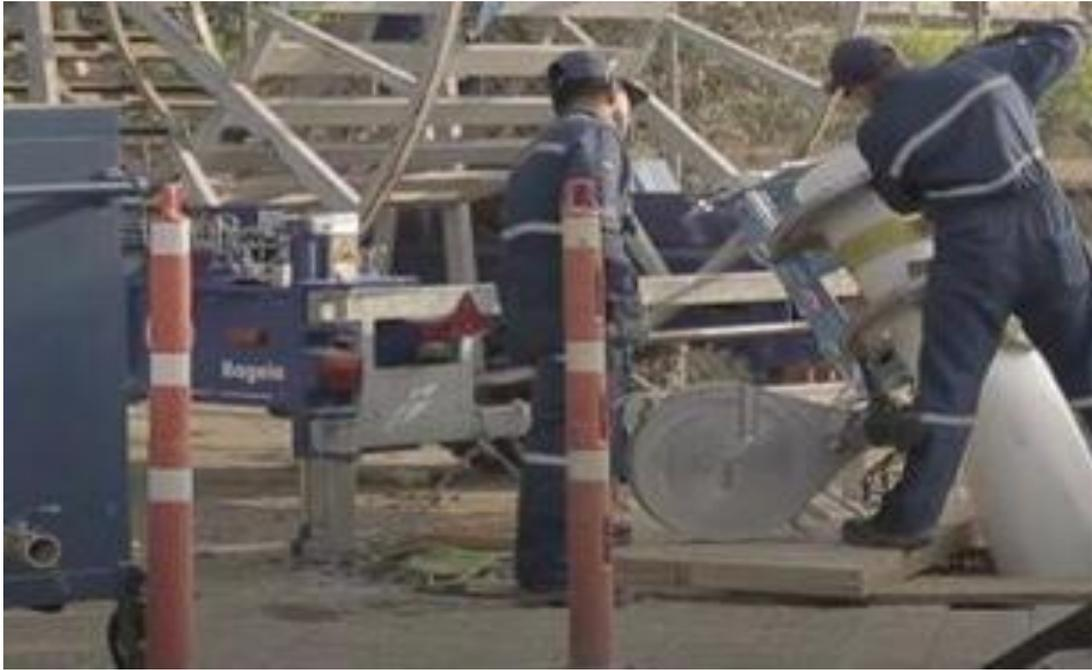
Figura 6.2.3. Canalización de tubería en colector afectado.
