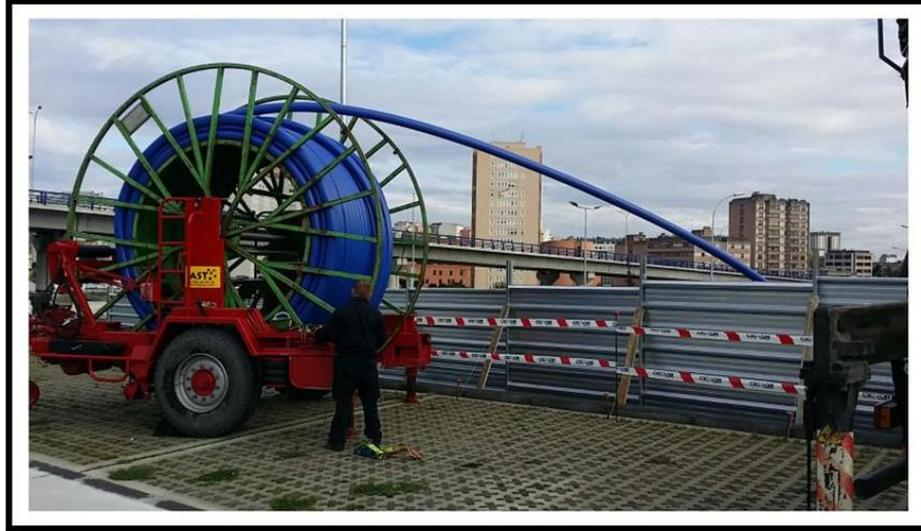
**Figura 15 Suministro a obra enrollado evita la manipulación y soldadura de tubería en obra, protegiéndola de los daños superficiales**
