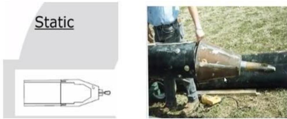
**Figura 8 Método Pipe Bursting Estático**
