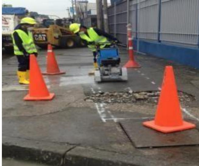
Figura 6.1.1 Perfilada de acera para la rehabilitacion del tramo.
