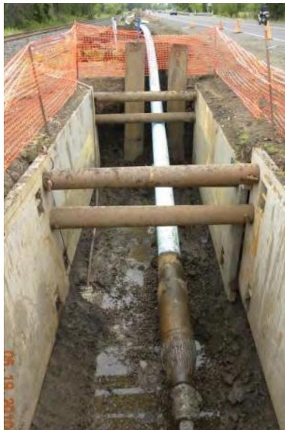
Figura 6.1.4. Instalación de colector de AASS por el método Pipe Bursting
