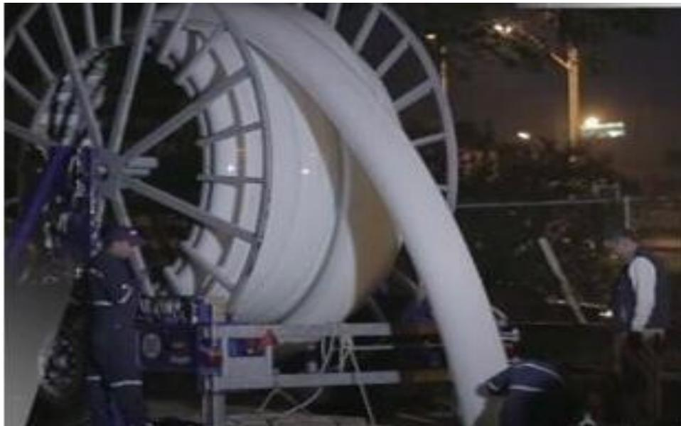
Figura 6.2.2. Carrete portador de tubería PEAD, canalización de tubería.
