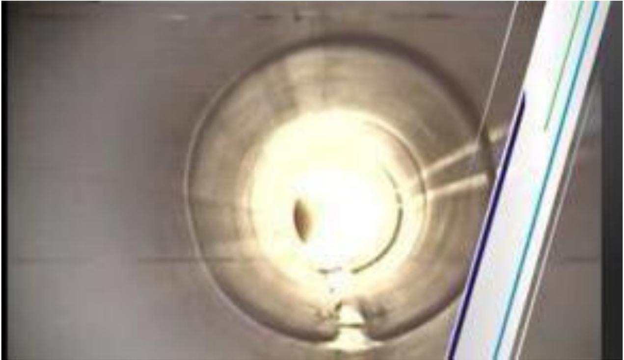
Figura 6.2.5. Inspección de tubería PEAD instalada en sitio con CCTV.
