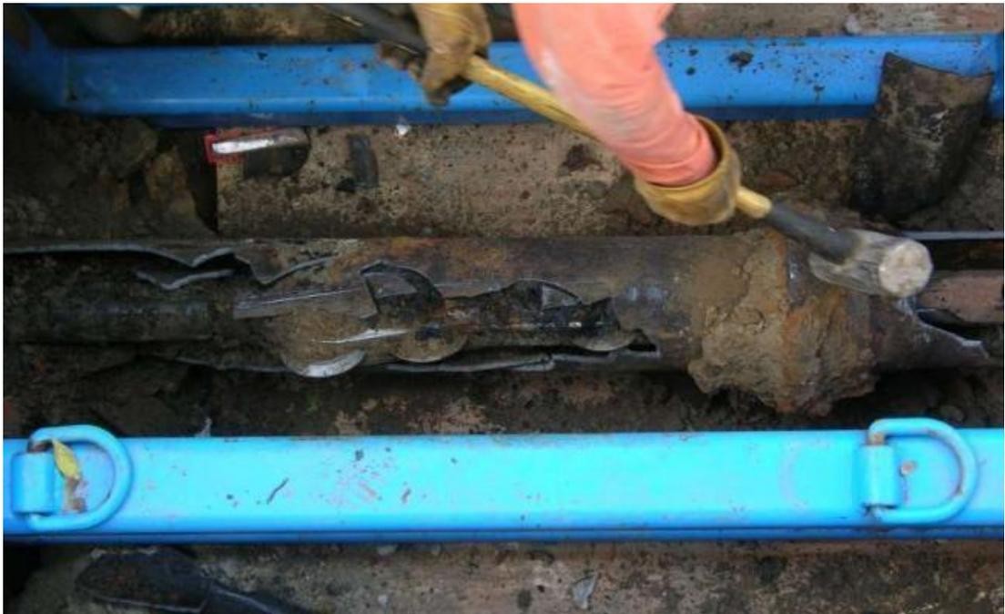
Figura 6.1.3. Perforación de la tubería existente
