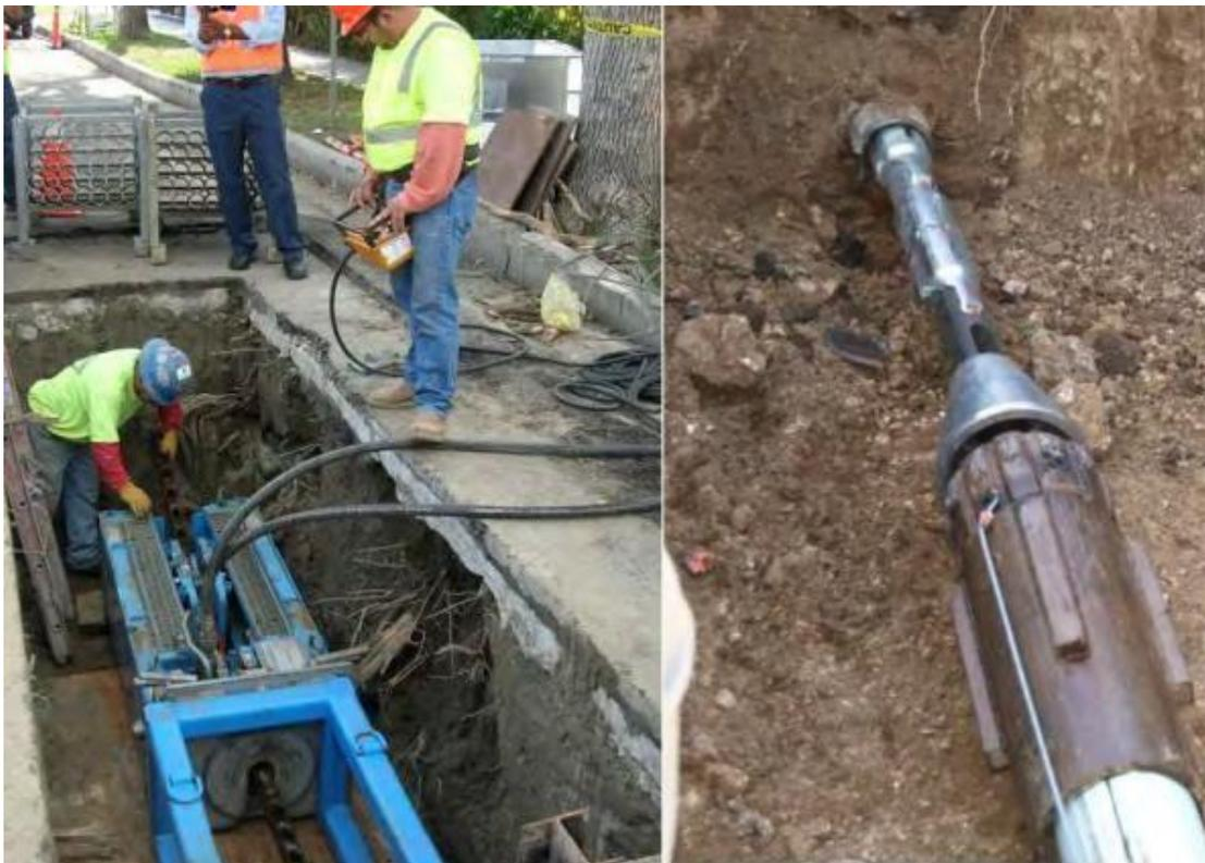
Figura 6.1.2. Winche arrastre de tubería Método Pipe Bursting y colocación del cabezal
