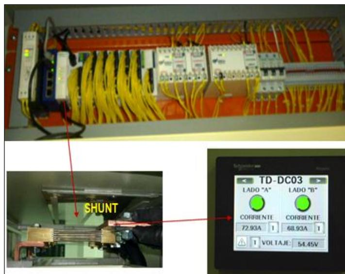
Figura 4.2 Shunt en PDU de centrales Conecel S.A. Guayaquil.
