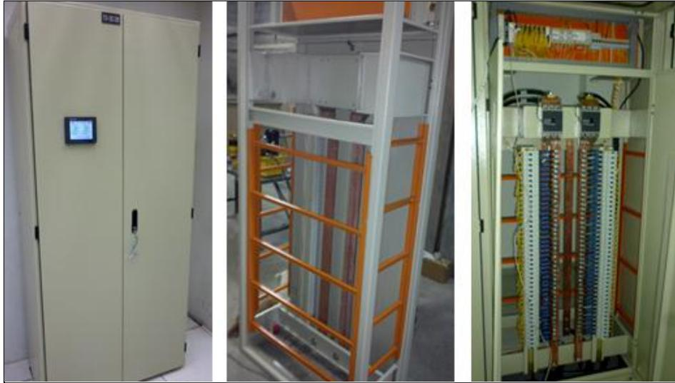
Figura 4.1 Gabinetes de Tablero PDU, Conecel S.A. Guayaquil
