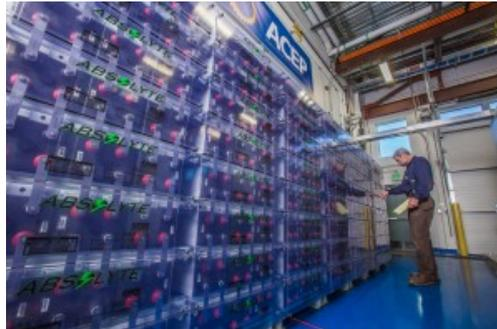
Figura 1.10 Banco de baterías para compensar excesos y defectos de energía instantáneos.
