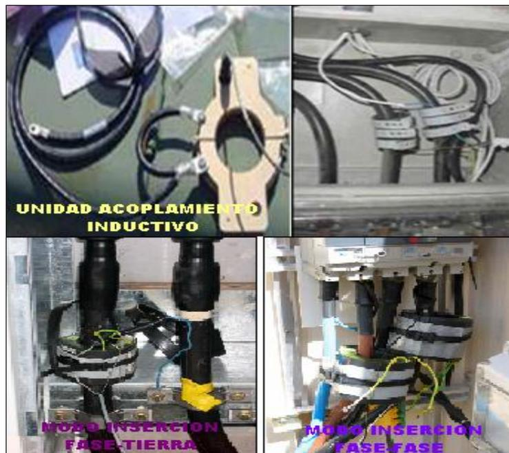
Figura 2.19 Unidad de acoplamiento inductivo BT y modos de inserción
