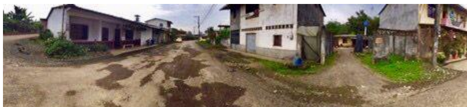
Figura 3. 4: Entrada principal del barrio “Las Gaviotas”. Elaborado por: Autor.
