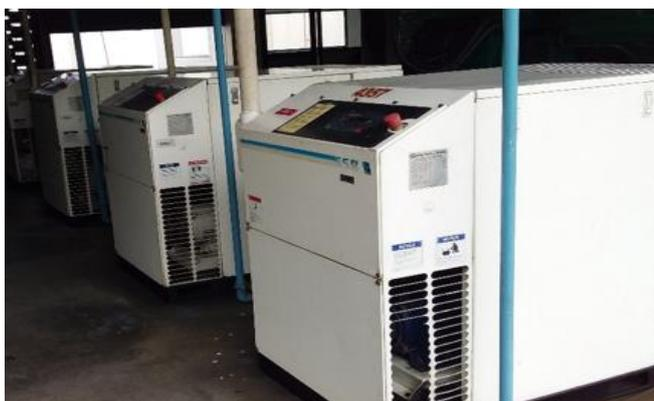
Figura 3. 1 Compresores Ingersoll Rand SSR-HP20 SE
