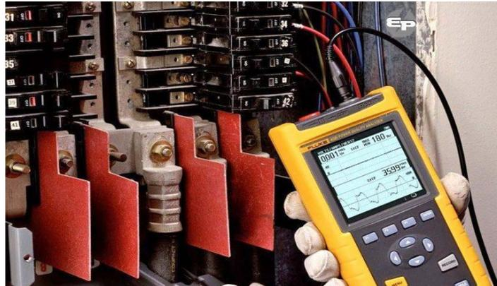
Figura 2. 4 Mediciones eléctricas para medir calidad de energía
