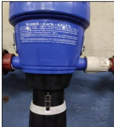
Figura 4. 32. Inyector Dosatron
