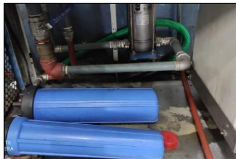
Figura 4. 3. Área de filtro de salida
