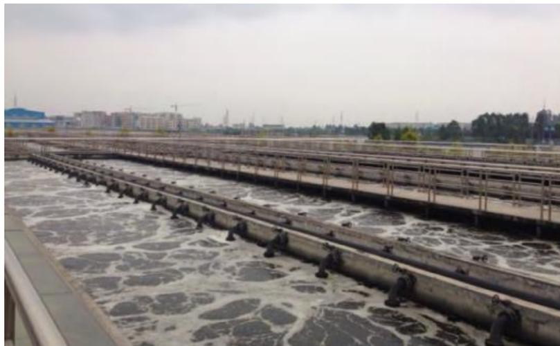
**Figura 16** Tanque de aireación en una planta de tratamiento de efluentes textiles en China
