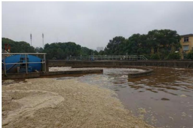
**Figura 17** Foto de una zanja de oxidación, China.
