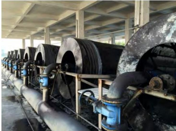
**Figura 12** Fila de tamices de tambor en una planta de tratamiento de efluentes textiles
