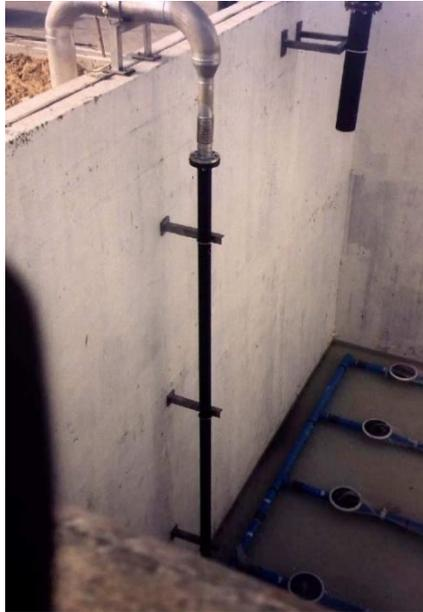
**Figura 6** Difusores de membrana circular en un reactor extraído para mantenimiento.
