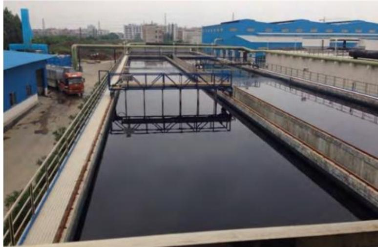
**Figura 13** Tanque de sedimentación rectangular de una PTAR en China
