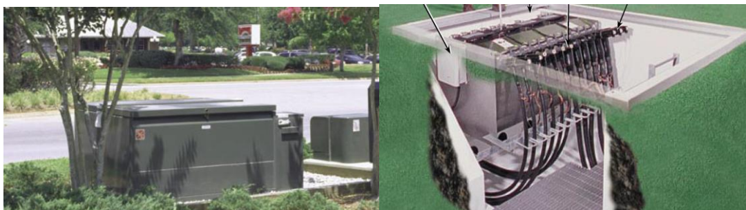
Figura 4. 12: Interruptor de distribución subterráneo tipo vista 15 KV. Fuente: http://www.technogroup.com.pe
