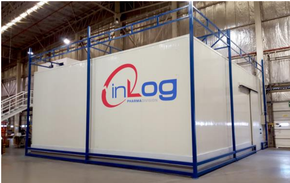
Figura 11. Cámara de Refrigeración en Instalación Logística. Tomado de Inlog Supply Chain Services(2021). https://www.inlogsupplychain.com/es/blog/105-la-logistica-farmaceutica
