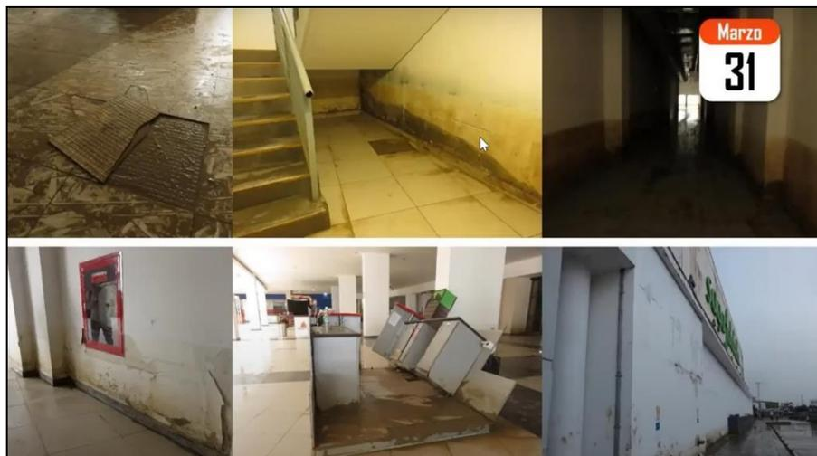
**Figura 15.** Fotografía de daños del centro comercial Open Plaza debido al desborde del río Piura 2017.
