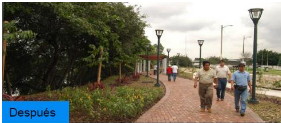
Ilustración 8. Construcción del Parque Lineal finalizada.
