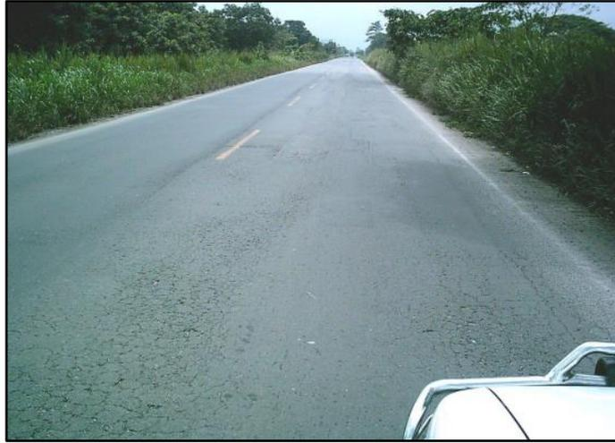
**Figura 6.** Agrietamiento por fatiga de tipo ascendente.
