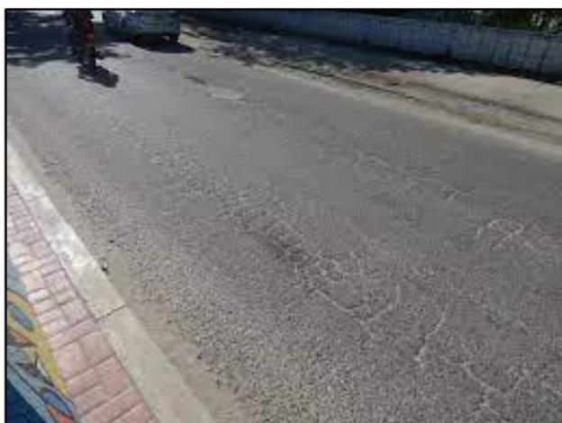
**Figura 9.** Agrietamiento por fatiga producto del envejecimiento de la mezcla asfáltica.
