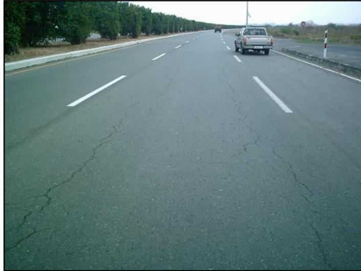
**Figura 7.** Agrietamiento por fatiga de tipo descendente.
