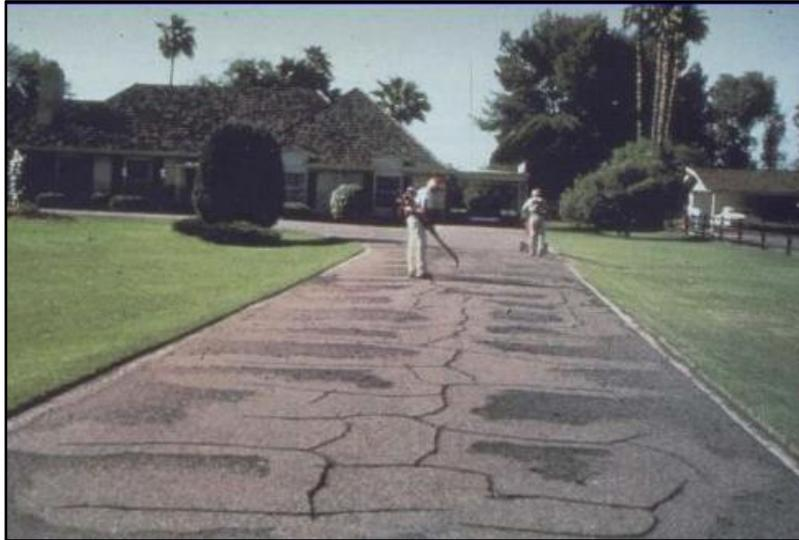
**Figura 10.** Agrietamiento en bloques producto del envejecimiento de la mezcla asfáltica.
