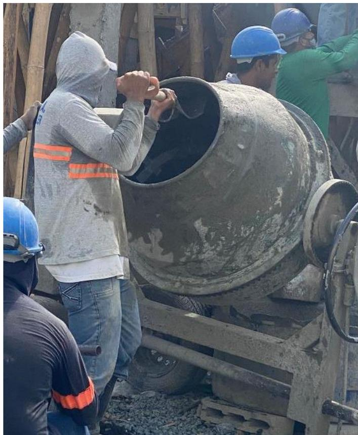
Figura 13: Despegada de mezcla de tambor detienen continuidad en proceso de fundición
