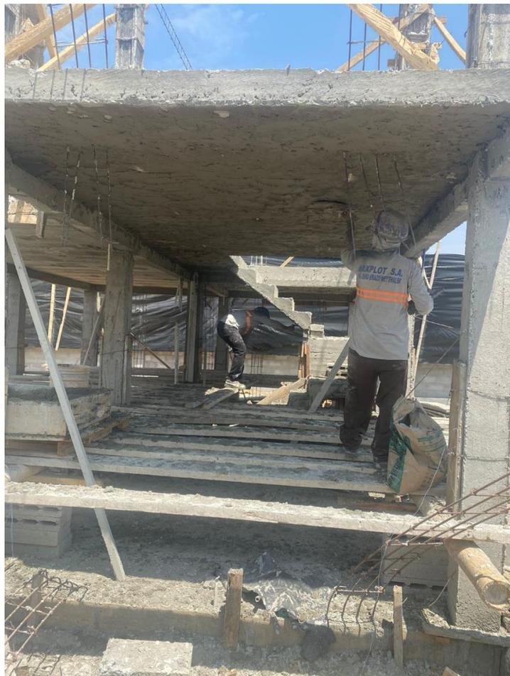
*Figura 17: Losa fundida*
