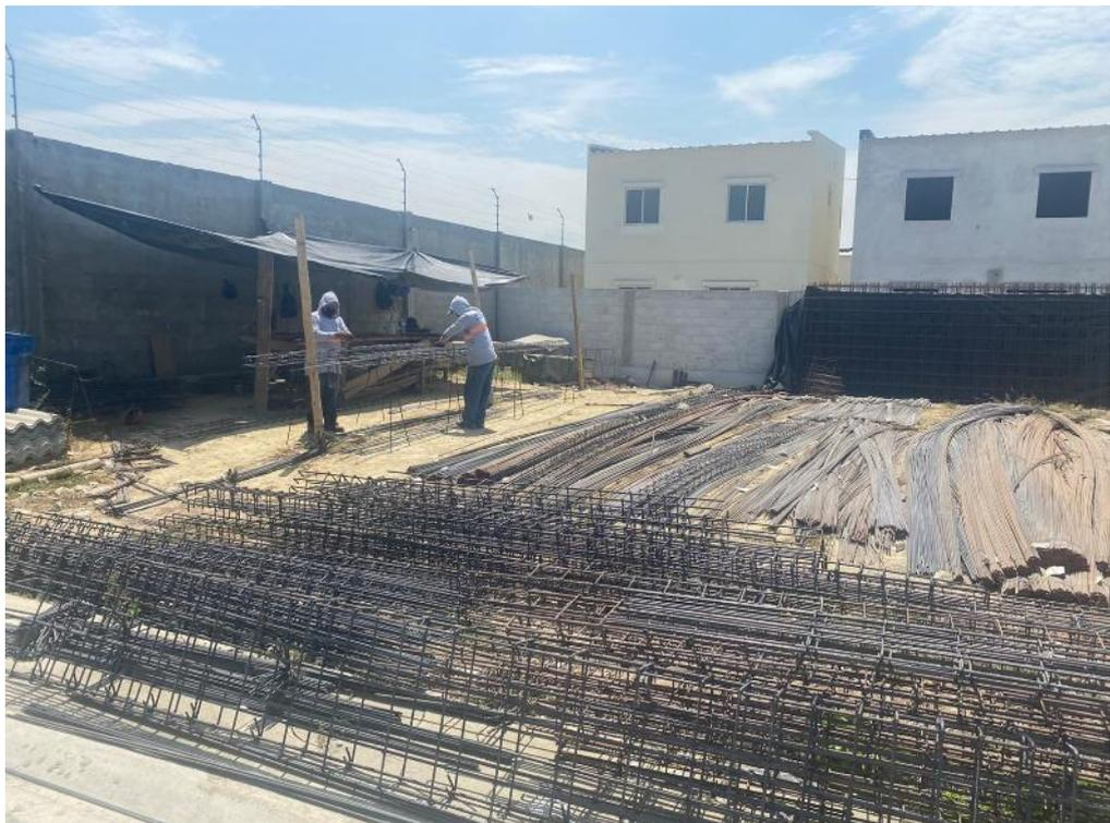
*Figura 9: Armando hierro para colocar sobre encofrado*
