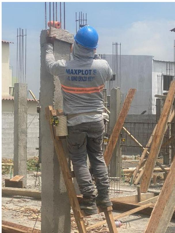
*Figura 3: Obrero en actividad de encofrado conocida como emboquillado*
