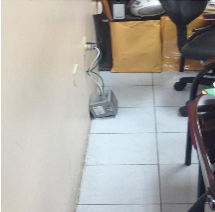
Figura 3.16 Instalación contador de eventos Eaton S.M.A.R.T.
