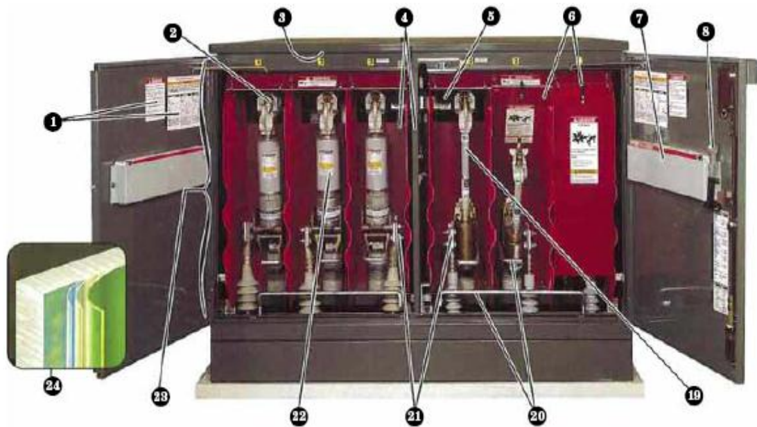
Fig. 4.2 Vista de lado del fusible de la unidad PMH. (S&C Electric Company, 2009)
