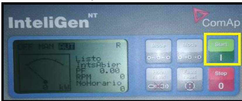
Figura 38 Indicador de encendido del generador
