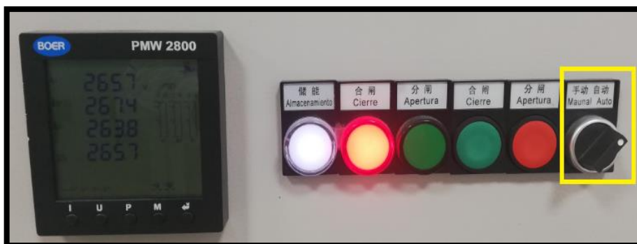
Figura 43 Selectores manual/automático
