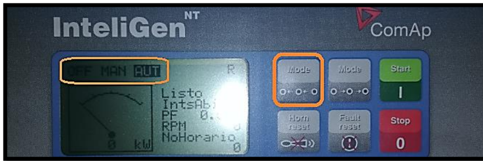
Figura 40 Indicador del modo automático del generador
