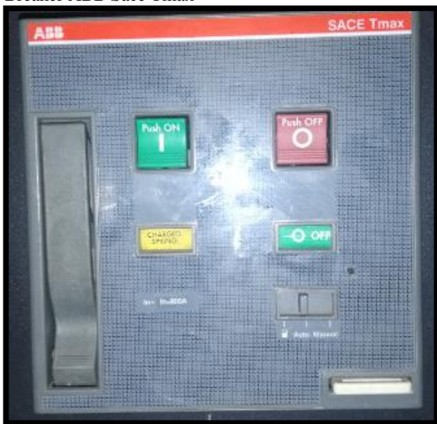
Figura 42 Breaker ABB Sace Tmax
