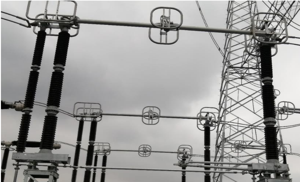
Figura 2 Seccionadores 500 kV
