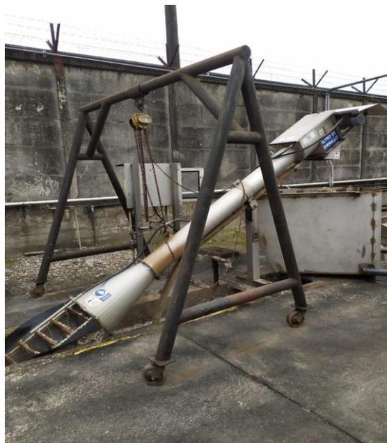
El agua residual con algunas partículas de menor tamaño el cual se los separa con un filtro cepillo rotativo como en la figura. La misma gira en dirección a las manillas del reloj y las aspás recogen el material residual y lo coloca en un recipiente para su posterior recolección.
