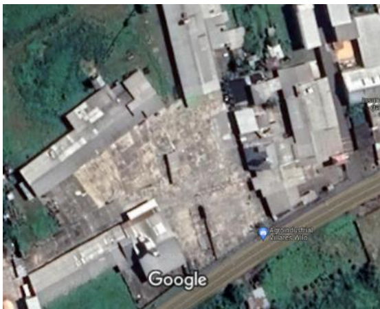
Figura 3. Locación del ensayo
