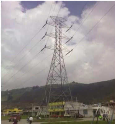
Figura 16: Torres de retención
