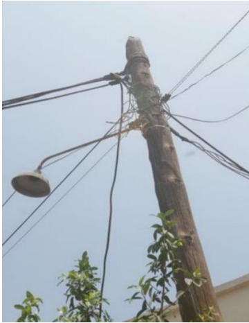
Figura 10: Poste de madera
