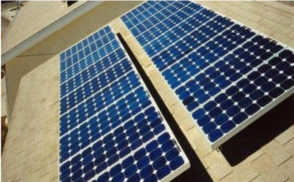
*Nota.* Panel solar monocristalino (Mono-SI) de silicio único. Adaptado de solar photovoltaic. Theseus, por (Wang & Lu, 2016, p. 26).
