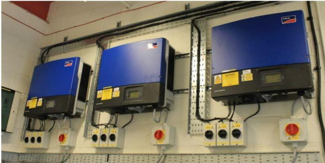
*Nota.* Inversores o convertidores utilizados en los sistemas fotovoltaicos. Adaptado de solar photovoltaic. Theseus, por (Wang & Lu, 2016, p. 16)
