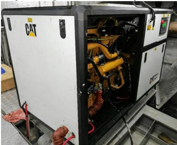
*Nota:* La ilustración muestra un grupo electrógeno C4.4 de marca Caterpillar. Se hace la apertura de una guarda del encabinado con el propósito de visualizar el equipo. El encabinado es desmontable, de manera que se puedan realizar trabajos de mantenimiento o reparación.
