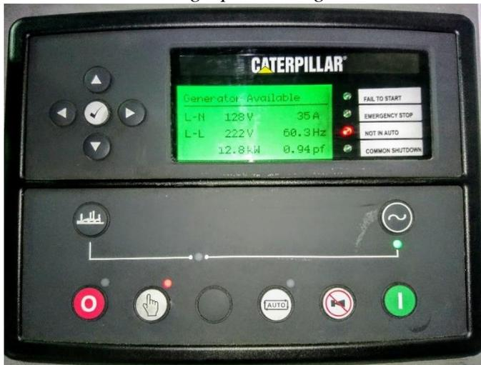
*Nota:* La ilustración muestra el panel de control de un grupo electrógeno C4.4. Se pueden observar los parámetros del generador como: Potencia, voltaje, amperaje, frecuencia y factor de potencia.
