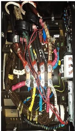
*Nota:* La ilustración muestra los componentes eléctricos y electrónicos del generador. Se puede visualizar el regulador de voltaje, los cables de salida para cada una de las fases, transformadores de corriente, etc.
