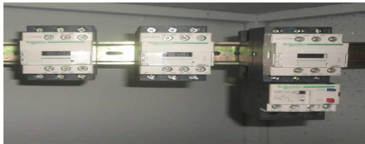
Fig. 4.3.- Térmico y Contactor
