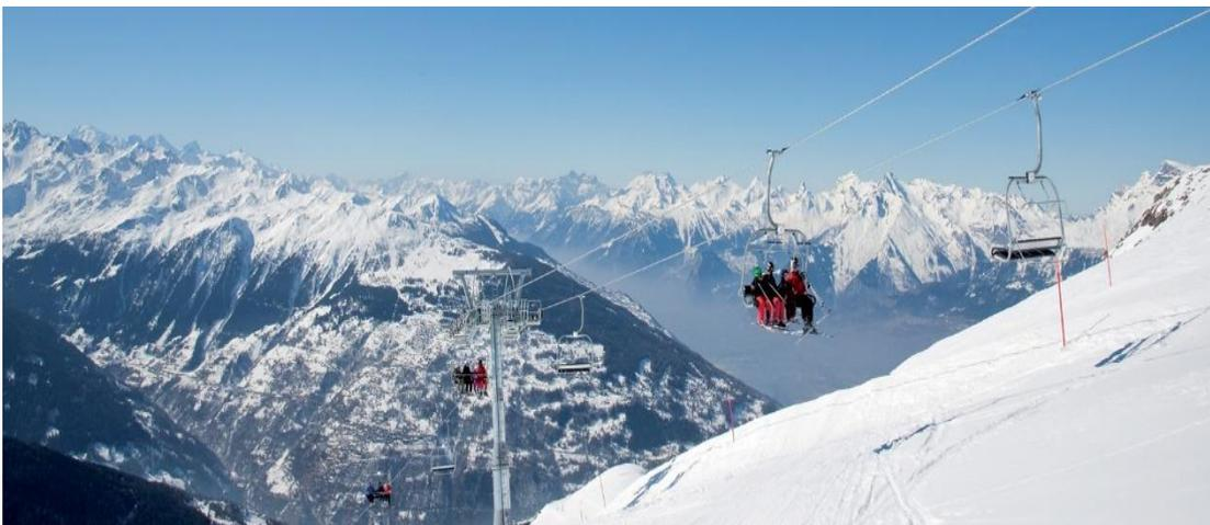
*Figura 10.* Sistema Telesilla de pinza fija.
