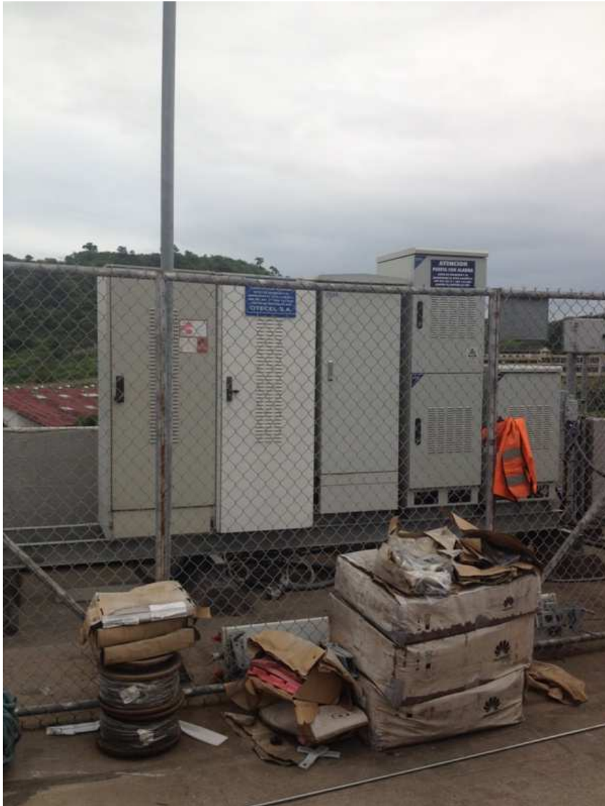
Radio base de Movistar en la terraza del edificio de cómputo.
