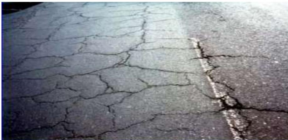
**Figura 7.** Agrietamiento por bloque.
