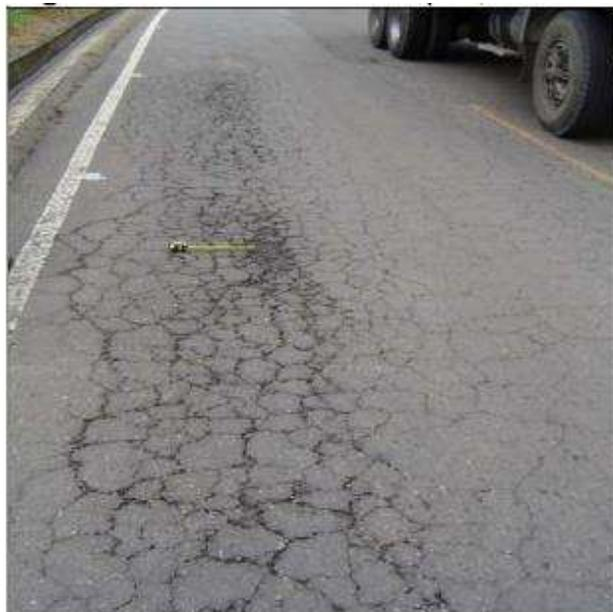
**Figura 5.** Agrietamiento por fatiga tipo piel de cocodrilo
