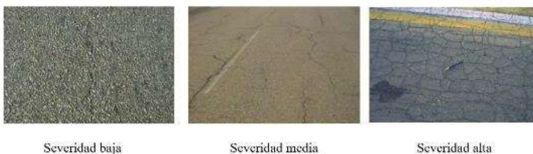
**Figura 4.** Tipos de severidad en grietas por fatiga.
