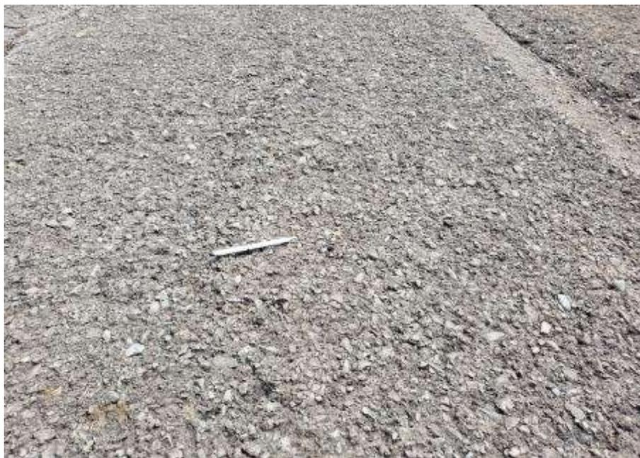
**Figura 8.** Pavimento antiguo con desintegraciones superficiales.
