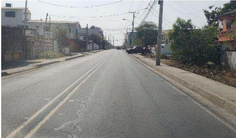
**Figura 6.** Agrietamiento por fatiga descendente en la vía Playas Posorja.
